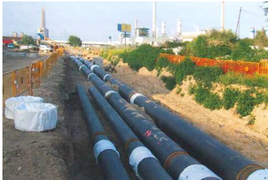
Figura 4 – Vista da montagem da usina de energia de Barcelona.
