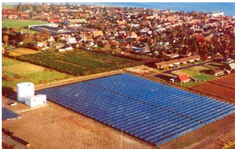
Figura 10 – Instalação de aquecimento distrital de Marstal 8000 m 2 na Dinamarca.
