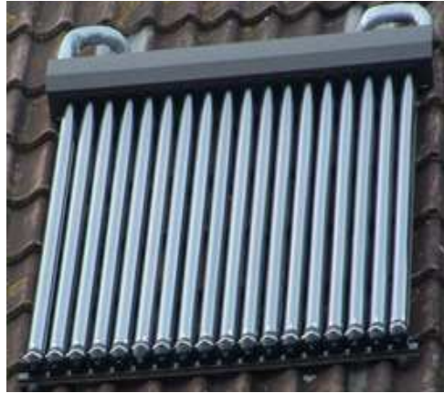
Figura 85 – Coletor solar de tubos evacuados.
