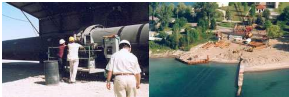
Figura 12 – Captação de água no lago Ontário para utilização no sistema de refrigeração distrital / abastecimento de água de Toronto.
