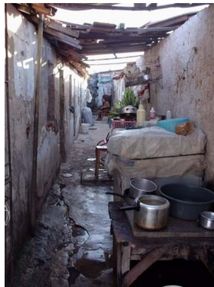
Figura 63 – Vista interna do corredor de acesso à residência de ex-salineiro localizada no Centro da cidade. Fonte: Arquivo pessoal, 2004.
