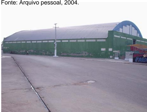
Figura 20 – Vista externa do Ginásio Municipal localizado no limite do Centro com a periferia da cidade. Fonte: Arquivo pessoal, 2004.
