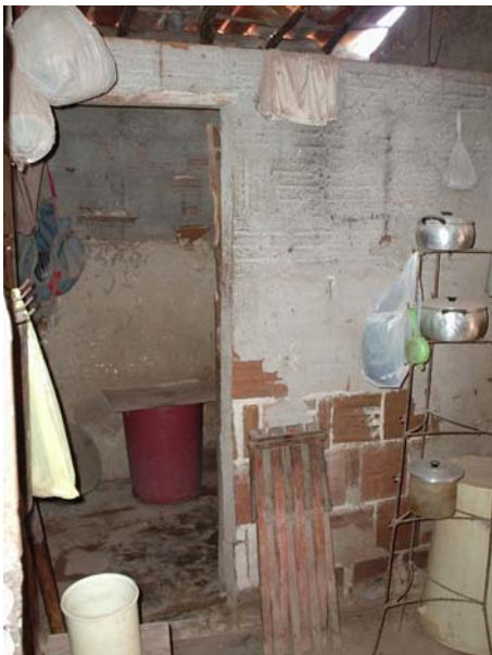
Figura 58 – Vista interna da residência de ex-salineiro localizada no Porto de São Pedro. Fonte: Arquivo pessoal, 2004.
