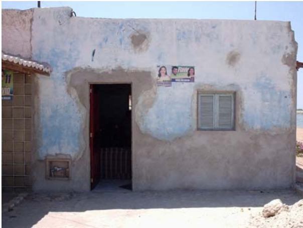
Figura 56 – Vista externa da residência de ex-salineiro localizada no Porto de São Pedro. Fonte: Arquivo pessoal, 2004.
