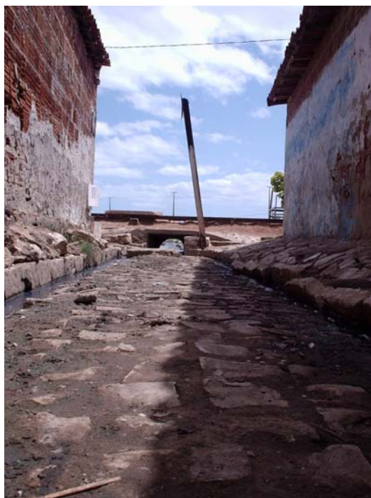
Figura 54 – Vista do encaminhamento da água servida para vala que despeja no Rio Açú. Fonte: Arquivo pessoal, 2004.
