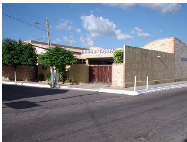
Figura 30 – Vista externa de uma residência localizada no Centro da cidade. Fonte: Arquivo pessoal, 2004.
