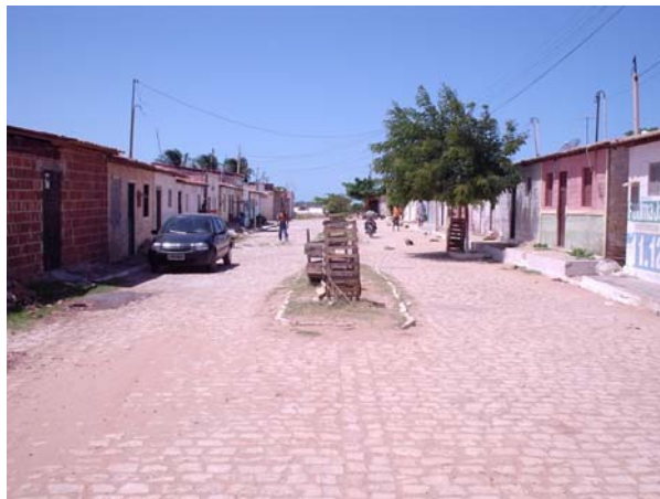
Figura 32 – Vista da rua Constance Macedo Lopes pertencente ao bairro Nossa Senhora dos Navegantes. Fonte: Arquivo pessoal, 2004.
