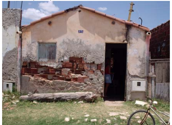
Figura 59 – Vista externa da residência de ex-salineiro localizada no Porto de São Pedro. Fonte: Arquivo pessoal, 2004.
