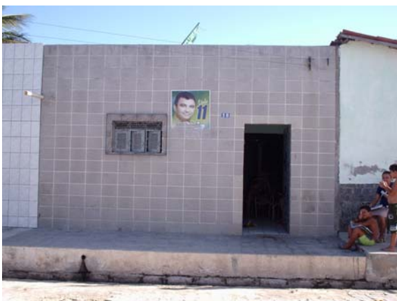
Figura 66 – Vista externa da residência de salineiro localizada no Porto de São Pedro. Fonte: Arquivo pessoal, 2004.
