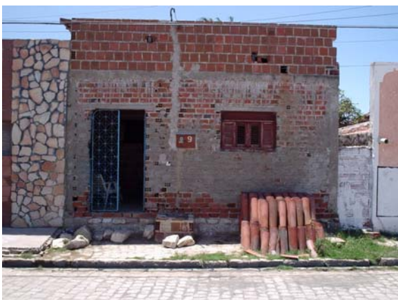
Figura 64 – Vista externa da residência de salineiro localizada no Porto de São Pedro. Fonte: Arquivo pessoal, 2004.
