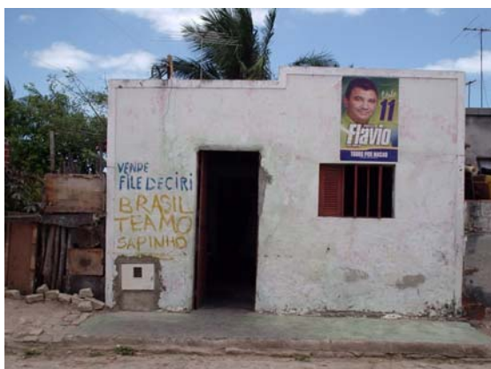
Figura 60 – Vista externa da residência de ex-salineiro localizada no Porto de São Pedro. Fonte: Arquivo pessoal, 2004.
