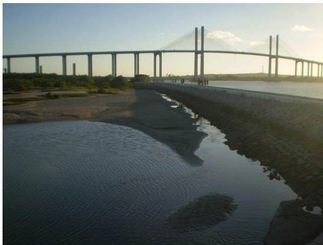
Foto 12. Ponte Nilton Navarro. Praia do Forte-Redinha. Natal-RN
