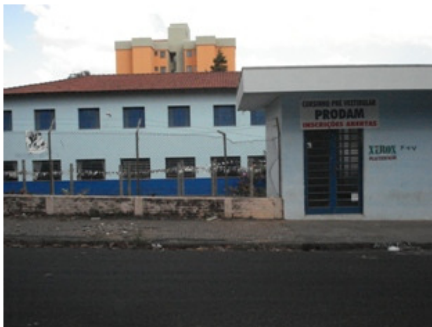
Figura 1: O Prédio onde funciona o Cursinho, em Maio de 2007, antes da reforma.
