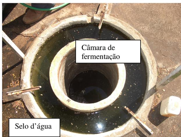
FIGURA 2 – Vista parcial do biodigestor batelada instalado no Departamento de Engenharia Rural utilizado no experimento, detalhe da câmara de fermentação e selo d'água.
