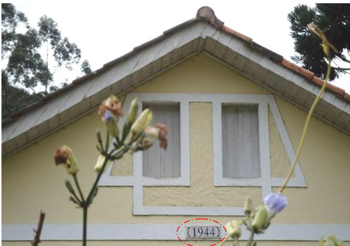
Fotografia 4 – Detalhe: frontispício da casa construída em 1941 / SMC.
