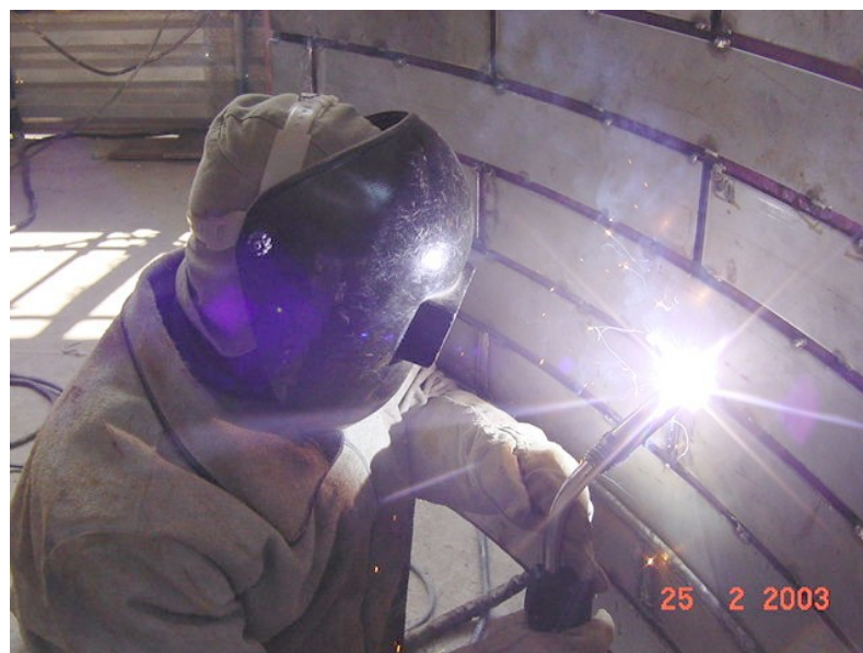
Figura 1 – Revestimento interno em torres de destilação (Balducci et al., 2004)
