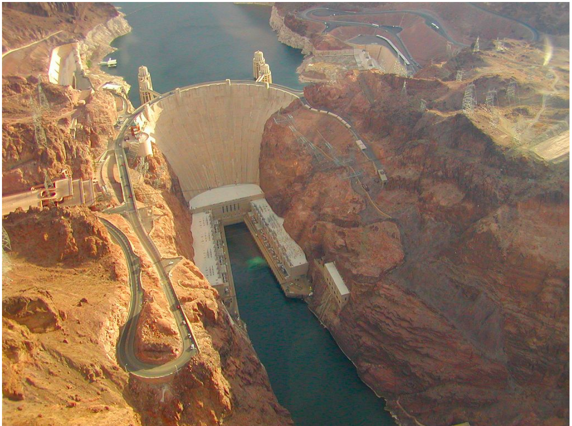
Figura 1.16.c: Barragem à arco
