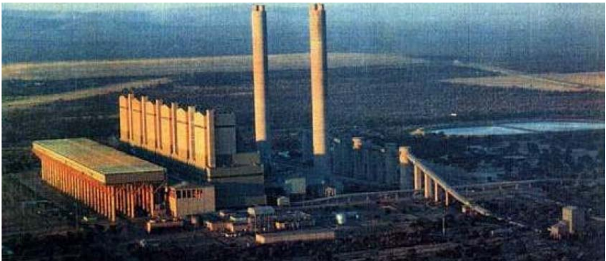
Figura 1.23.c: Central térmica à vapor de Matimba, África do Sul, 4000MW
