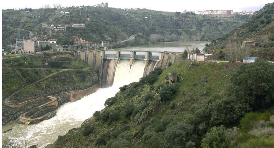
Figura 1.16.a: Barragem à gravidade
