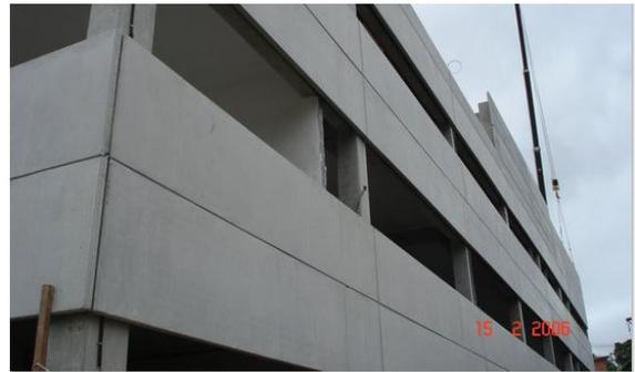
Figura 2.1: Exemplos de aplicação de painéis horizontais em fachada (UEHARA)
