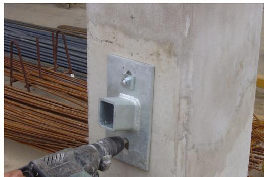
Figura 3.23: Ligação de encaixe utilizado (Leonardi Pré-fabricados Ltda)
