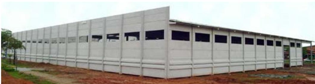
Figura 2.2: Painéis de fachada horizontais entre pilares (UEHARA)
