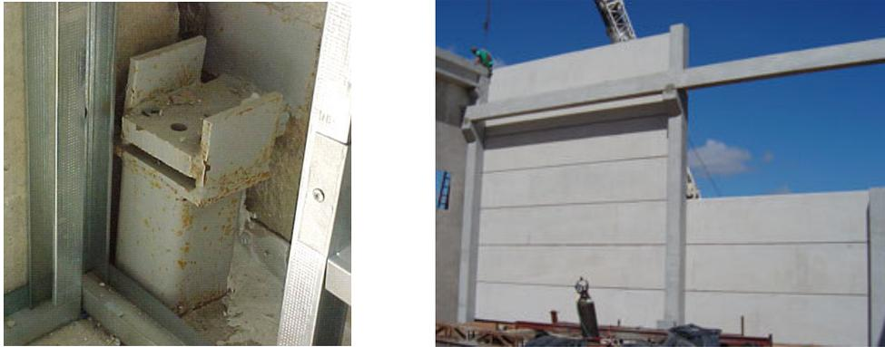
Figura 3.1: a) aspecto interno para painel de fachada arquitetônico; b) aspecto interno atualmente exigido para painéis horizontais (UEHARA).
