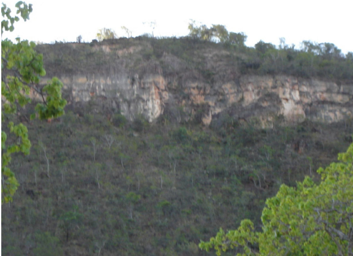
Fotografia tirada em 30/10/2006 na estrada entre Buritinópolis e Mambai
