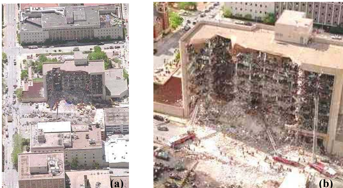
Figura 1.3: Fotos aéreas (a) e (b) do Prédio Federal Murrah na cidade de Oklahoma após a explosão terrorista em 1995 [K-9 Search & Detection, 2004].
