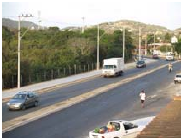
FIGURA 29 - O primeiro trecho da Via Azul ligando o Centro à entrada da Tartaruga. Prioridade para canteiro central em detrimento das calçadas e ciclovia, não agradou o Fórum das Entidades Cívicas (FECAB), que luta pela humanização da avenida.
