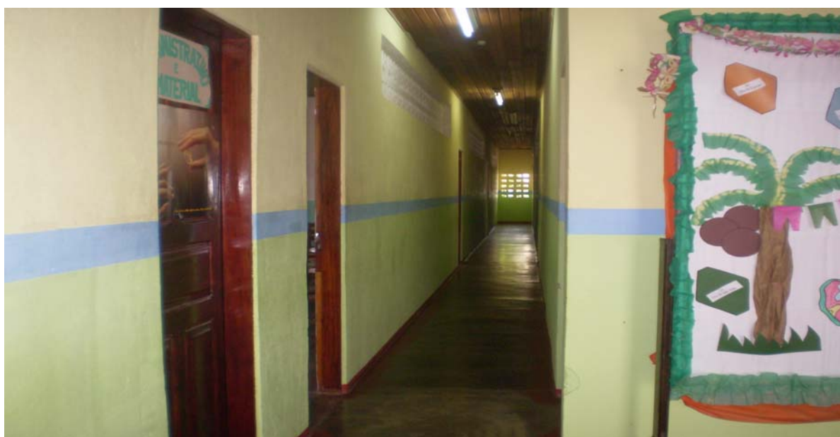
Foto 4: Corredor de acesso as salas de aula da E.E.S.J./2008. fonte: Arquivo particular do autor.
