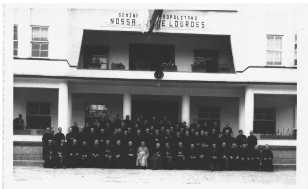
Figura 3 - Foto do dia da inauguração do atual prédio do Seminário de Azambuja, aos 7 de setembro de 1964.
