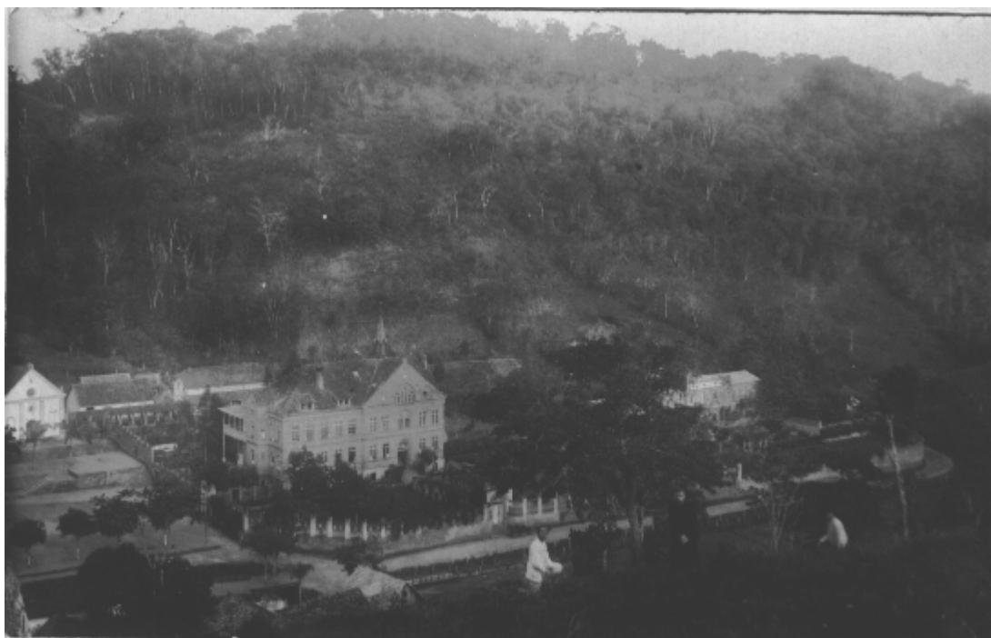
Figura 4 - Azambuja em 1927. O prédio maior, que se destaca do conjunto, é o prédio em que funcionava o Hospital Episcopal de Azambuja e no qual também irá funcionar o Seminário de Azambuja, no 2º e 3º piso, a partir de 1927.
