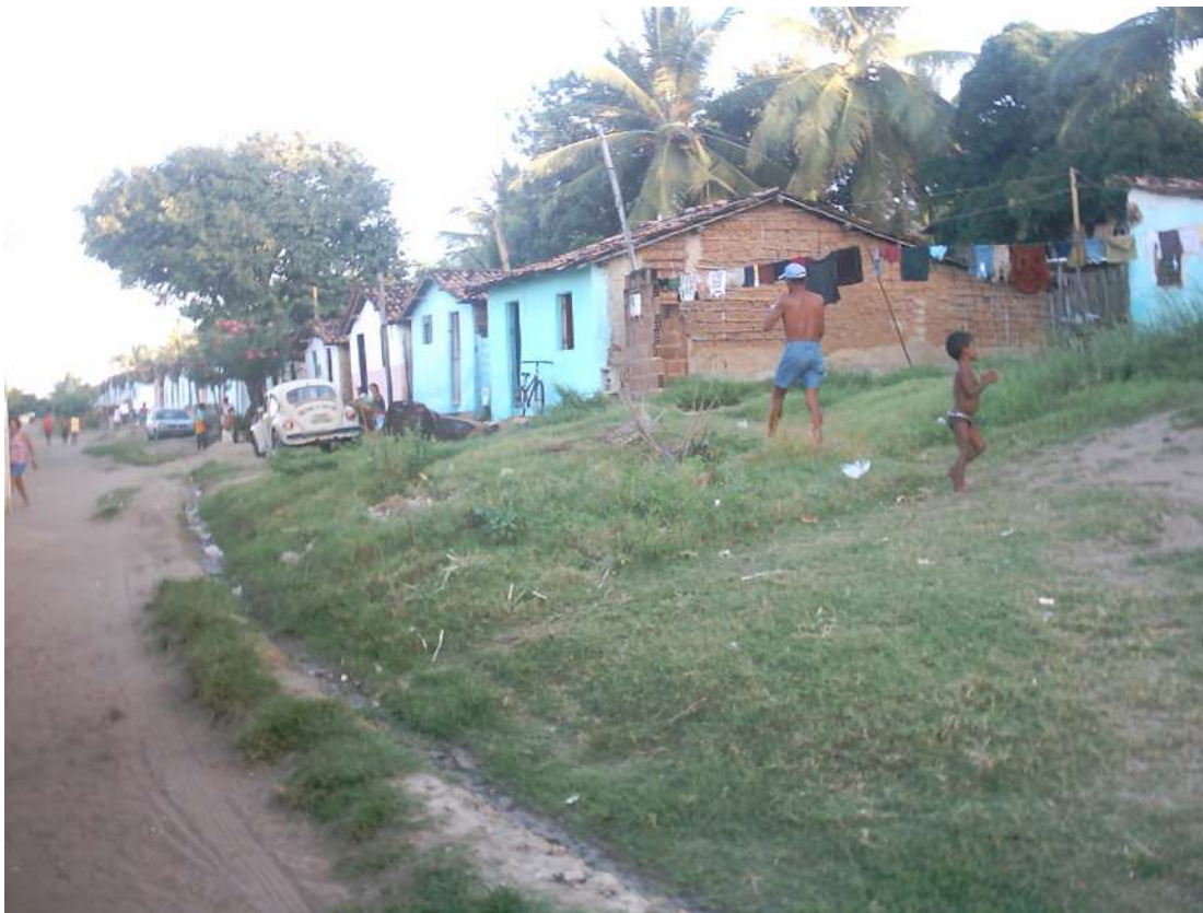
FIGURA 26: Vista da rua Manoel Bonifácio de Souza (conhecida como rua do Péla ), situada na encosta da duna. Repare a falta de infra-estrutura e as precárias condições de saneamento e habitação.
