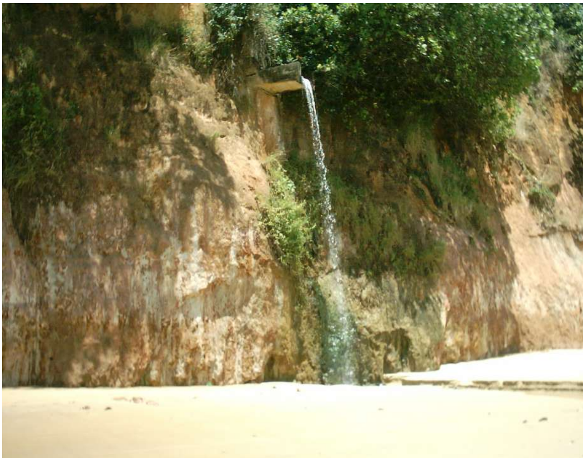
FIGURA 19: Vista do desaguadouro da galeria de esgotos na Praia do Porto, que por esse motivo pode se tornar poluída e imprópria para o banho de mar. Fonte: Carlos José, 2003.
