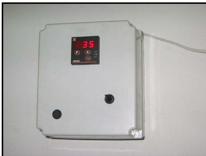
Figura 4.8- Regulador eletrônico de temperatura
