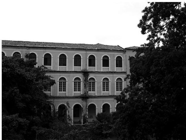
Figura 124 – Vista do Pátio Interno do Hospital Pedro II, Recife, 2006 Foto da Autora
