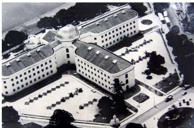
Figura 180 – Vista aérea do conjunto após sua restauração Fonte: Fundarpe
