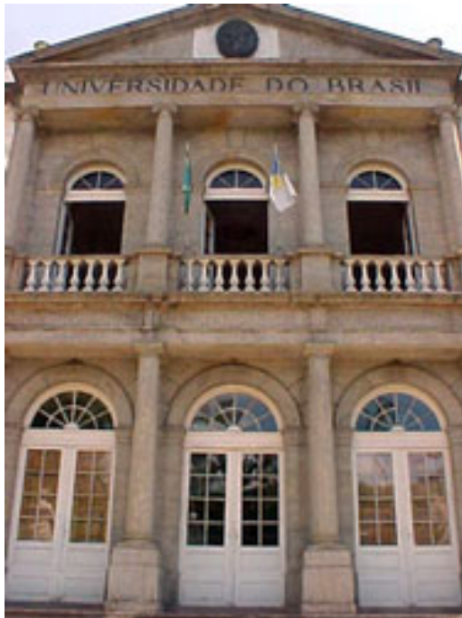
Figura 115 – Pórtico de acesso principal todo em cantaria de pedra Fonte: Escritório Técnico da UFRJ
