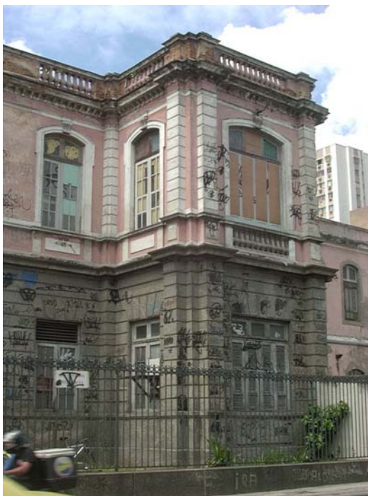
Figura 160 - Detalhe da fachada principal Fonte: Escritório Técnico da UFRJ.
