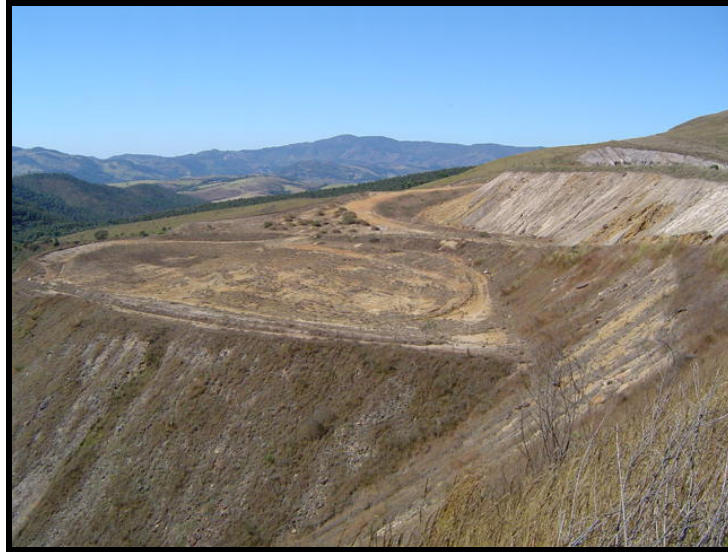
Figura 3. 5 – Vista parcial do talude principal do bota-fora BF4. Na base deste talude encontra-se o dreno principal e a lagoa de contenção de drenagem ácida (BNF).
