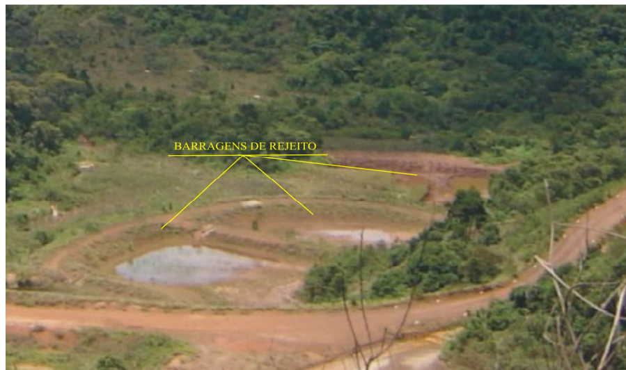
Figura 5.26 – Barragem de decantação dos finos gerados pela atividade mineira.
