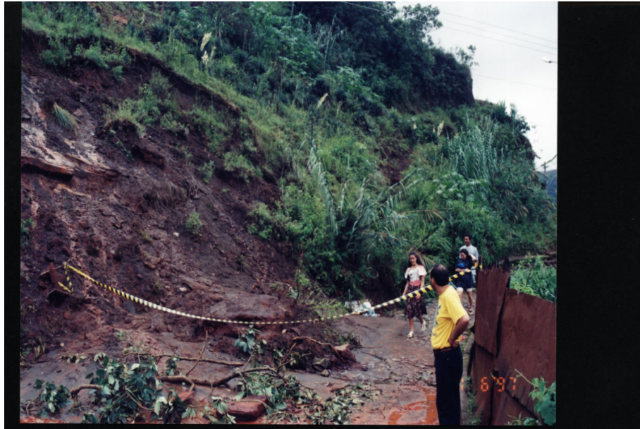
Figura 5.8 - Escorregamentos devido ao saturamento do material de topo em contato com a superfície impermeável.
