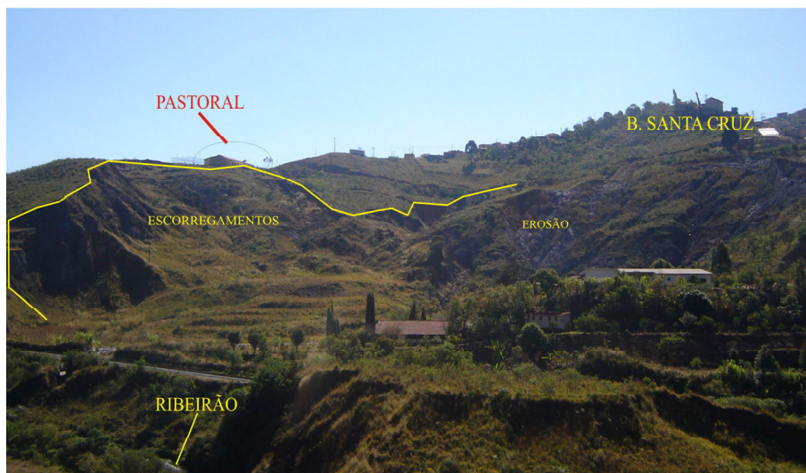
Figura 5.16 – Aspecto atual da área da cava (LV 01) na margem esquerda (norte), com intensa atividade erosiva e ocupação nas proximidades.
