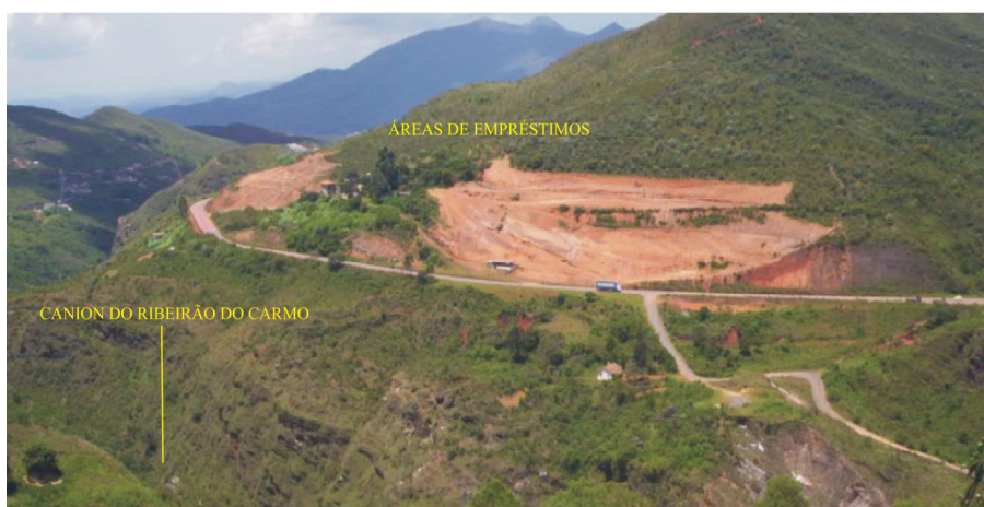
Figura 5.27 - Área típica utilizada para tomada de material de empréstimo
