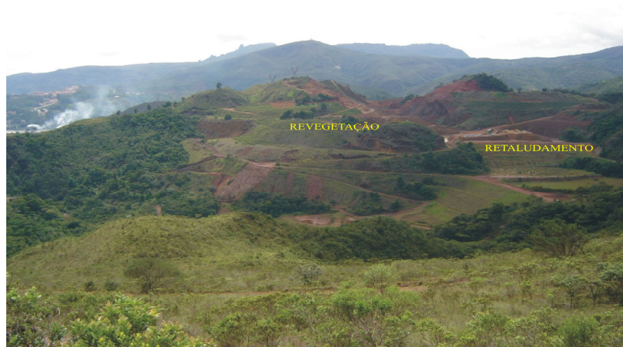
Figura 5.25 - Revegetação dos taludes originadas pela lavra.
