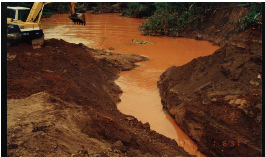
Figura 4.4 – Rompimento do aterro na Volta do Córrego (1997), ocasionando uma corrida de detritos que destruiu vários imóveis.
