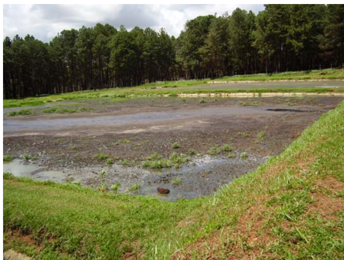
Figura 4.4 - Leito de secagem do lodo anaeróbio.
