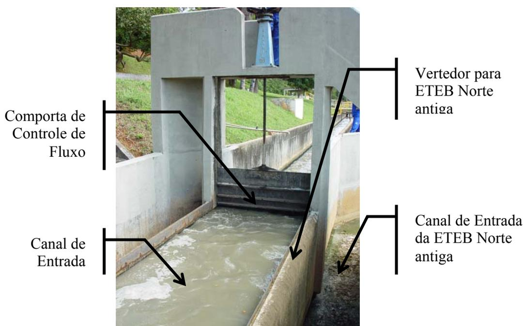
Figura 4.2 – Ponto de Separação do Fluxo Regularizado e do Excedente
