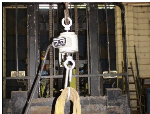
Fig. 7.12: Célula de carga acoplada à ponte rolante.
