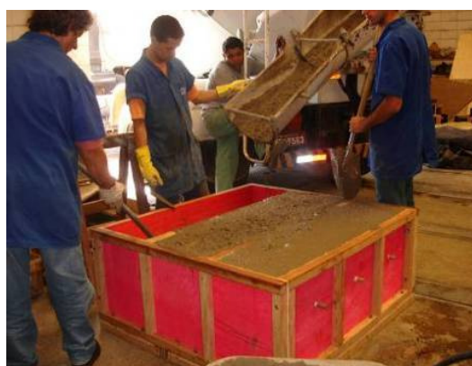
Fig. 7.9: Concretagem dos pesos mortos.
