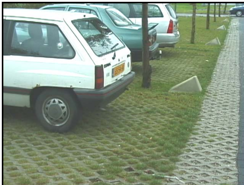
Figura 3.5 – Exemplo de pavimento permeável (CETE DU SUD-OUEST, 2003).
