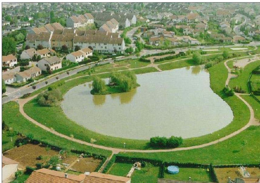
Figura 3.3 – Exemplo de bacia de detenção com água (Pompêo, 1998).
