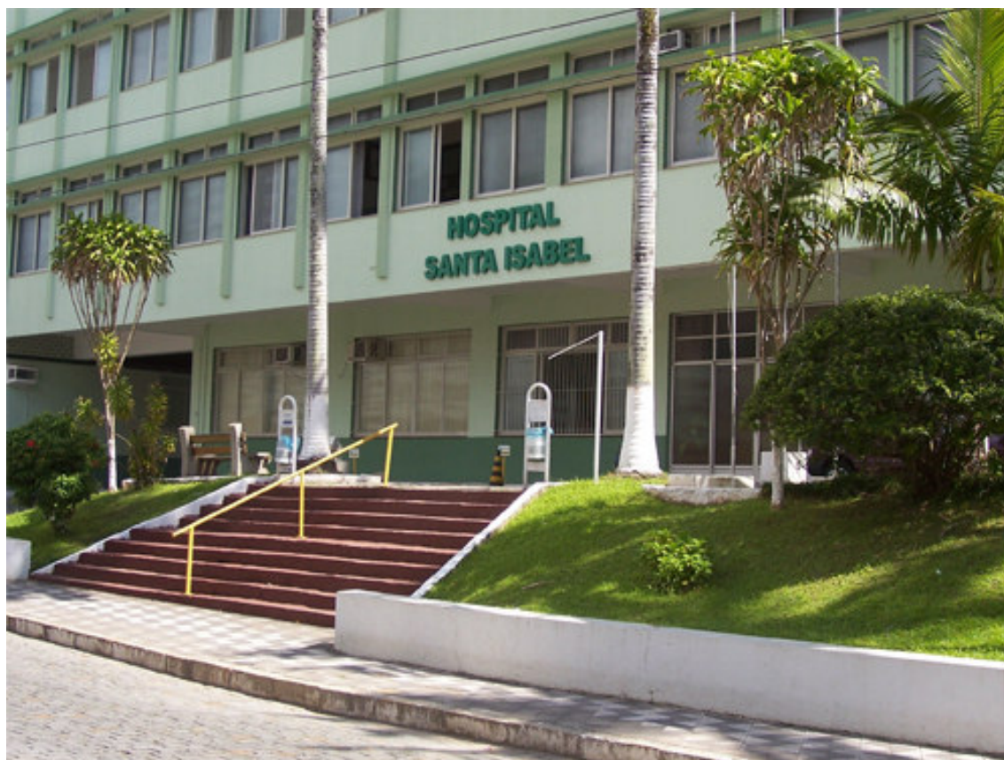
Figura 3 - Entrada principal do Hospital Santa Isabel na atualidade
