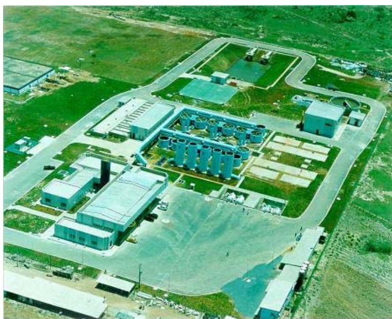
Figura 4.4 - Foto da ETA pípiripau
