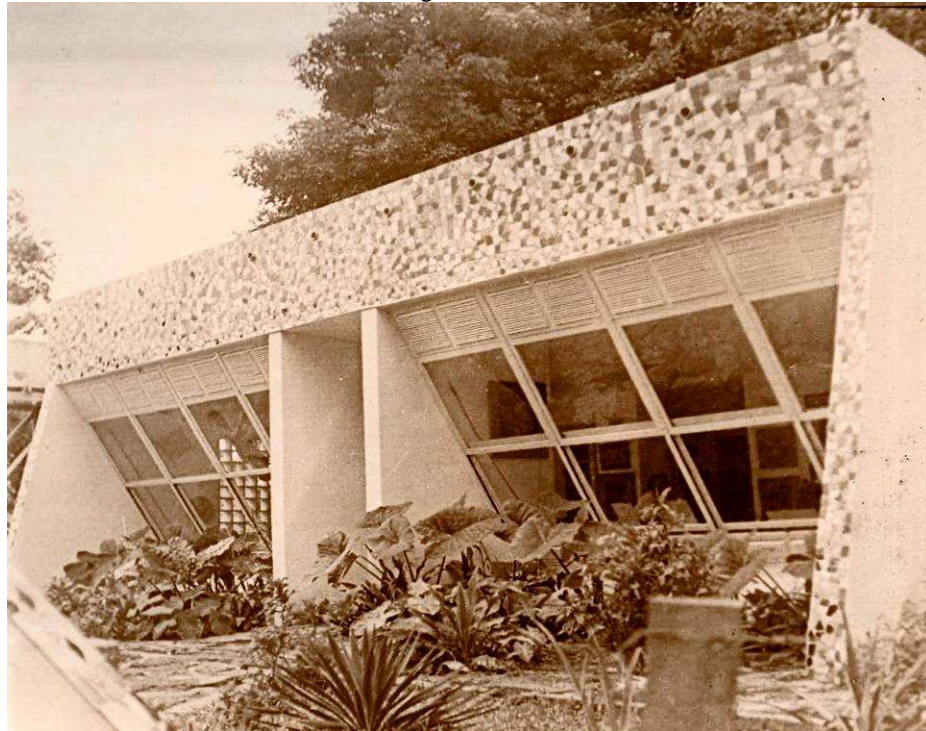
IMAGEM 5: Residência de Ruy Meira na Ilha do Mosqueiro, circa 1952. Fachada. Fotografia de 1953.
