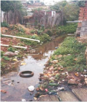
Figura C.29 - Trecho a jusante do canal, recebendo esgoto e lixo - Jaguaquara.
