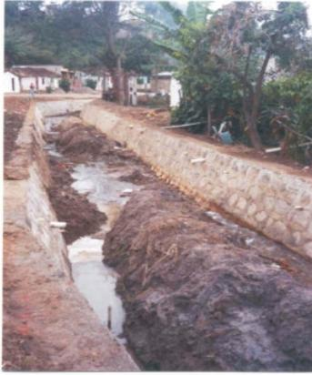
Figura C.27 - Canal em construção em Jaguaquara, afluente do rio Jiquiriçá.
