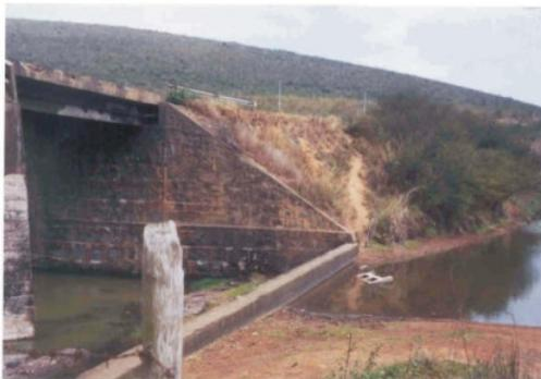
Figura C.25 - Ponte na BR-116. Detalhe da ponte sob o rio Jiquiriçá e do vertedor.
