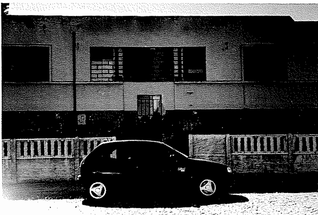
Foto 4- Escola B, antes da municipalização
