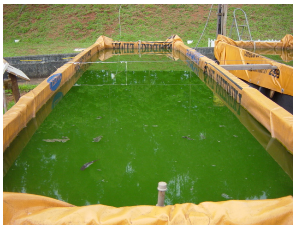
Figura 5.63: Flutuação de lodo (19/02/04 – 18:03)
