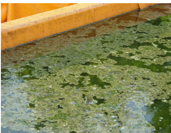
Figura 5.71: Lodo formando uma fina camada superficial concentrado próximo às bordas laterais (02/03/04 – 07:59)
