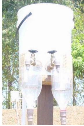
Figura 4.9a: Caixa de passagem 1 com registro de gaveta na saída para controle de vazão
