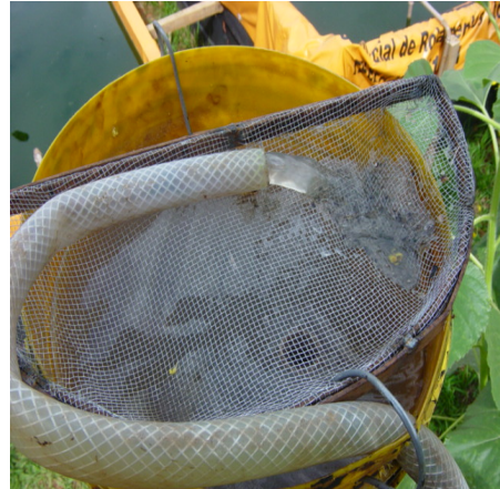
Figura 4.6. Tela antes da caixa de passagem 1
