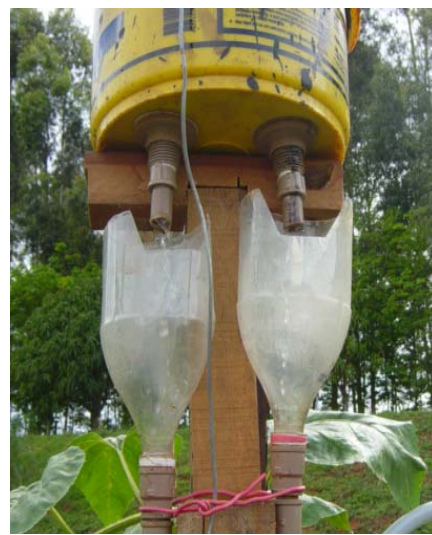
Figura 4.8b: Saída em queda livre da caixa de passagem 1
