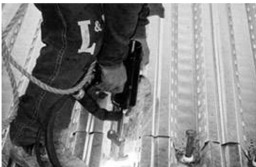
Figura 2.7 Colocação de stud bolts (www.metlica.com.br)
