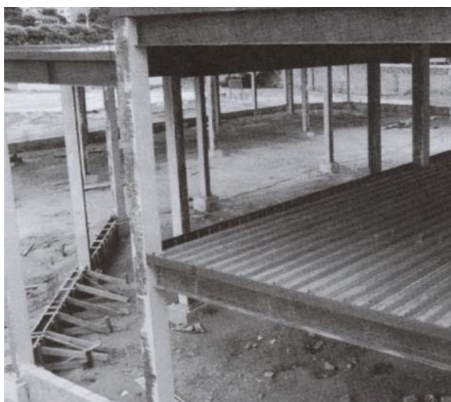
Figura 2.9 Pilar misto parcialmente revestido (Queiroz, 2001).
