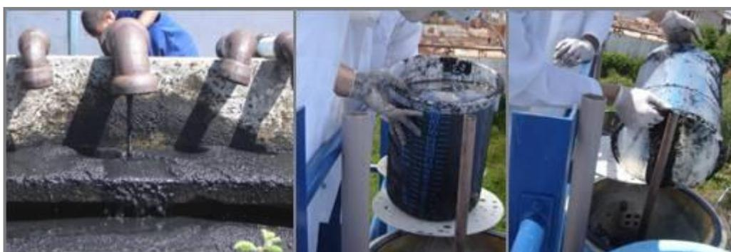
**Figura 4.3 - Inoculação dos reatores anaeróbios.**
