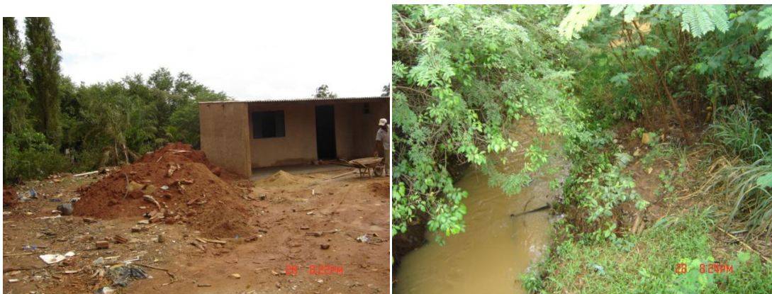
Figuras 2 e 3 – construção junto a APP em Catiguá Acervo da Polícia Militar Ambiental de Catanduva/SP, em 28/8/2005.
