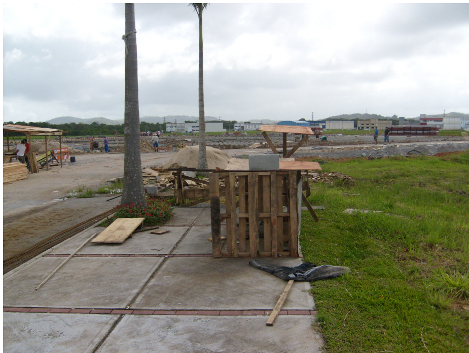
Figura 42: Obras iniciais do setor central
