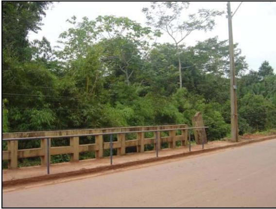
Foto 27 – Ponte da Estrada do Calafate. Mata ciliar preservada a jusante.
