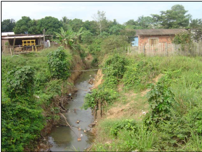
Foto 1 - Construções à margem do igarapé e resíduos (lixo) lançados no leito. Bairro da Paz.
