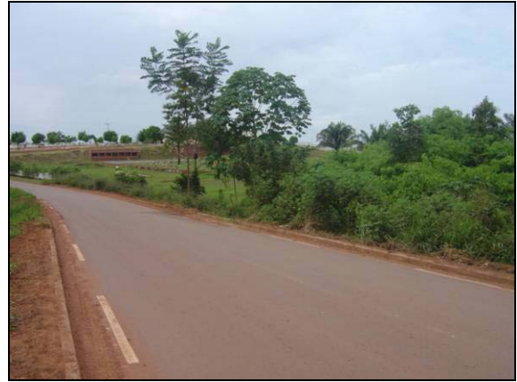
Foto 28 – Ponte da Estrada do Calafate. Cemitério ao fundo.
