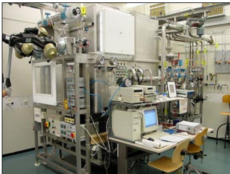
Figura 2.3.2: Vista externa da célula quente Caisson
