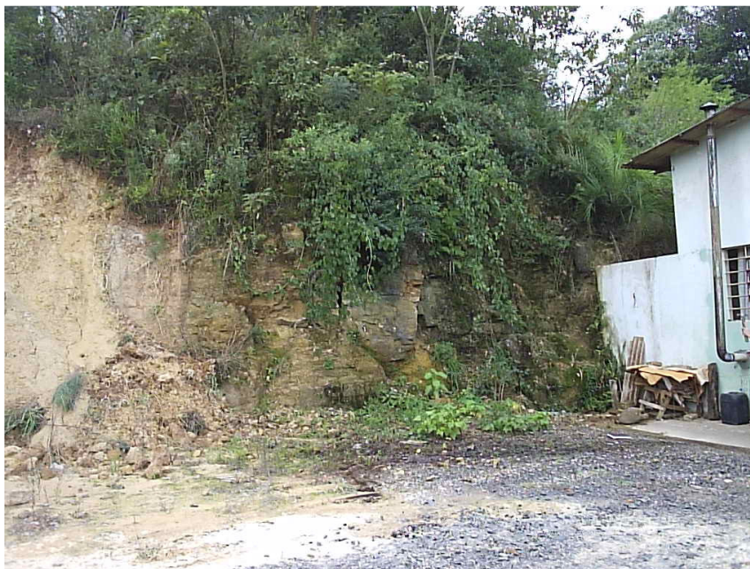
Figura 35: Área desmoronada do Afloramento Santa Paula, sentido residência.
