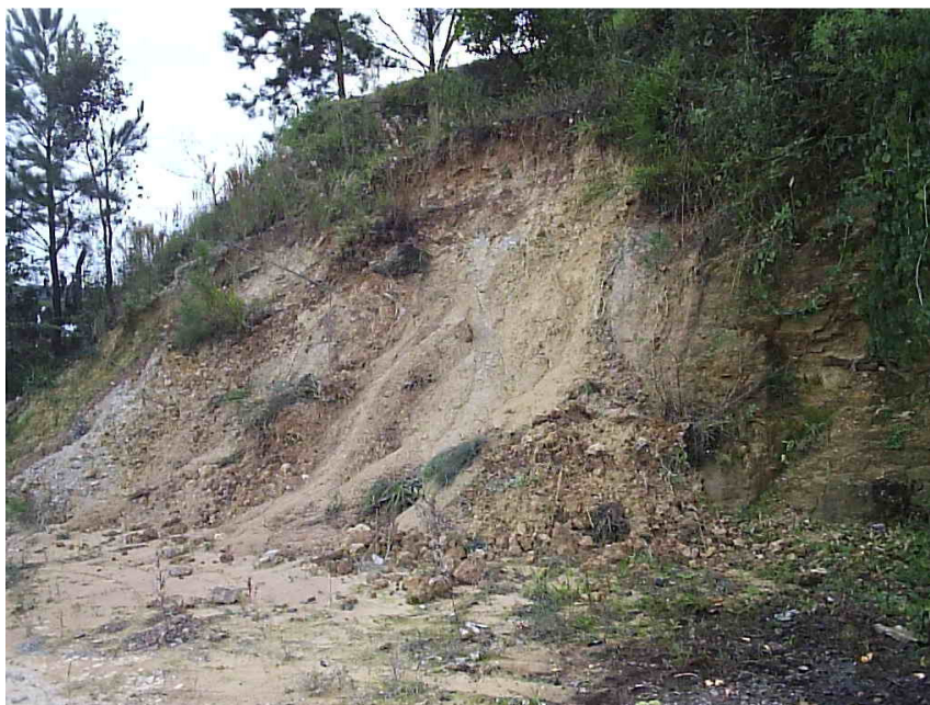
Figura 36: Área desmoronada do Afloramento Santa Paula, sentido Avenida Rotary Club de Ponta Grossa.
