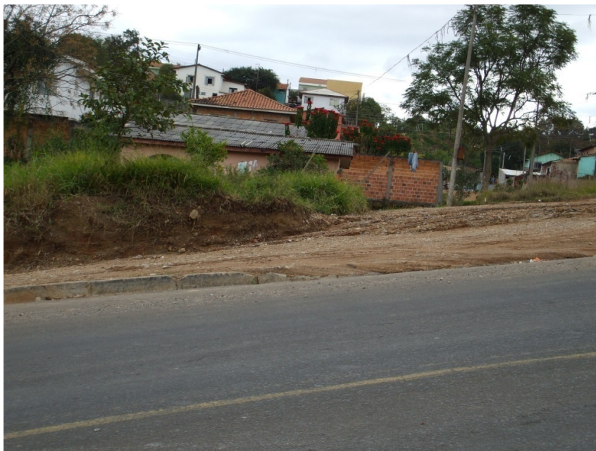
Figura 16: Corte da rua sobre o Afloramento Curva Vilela.
