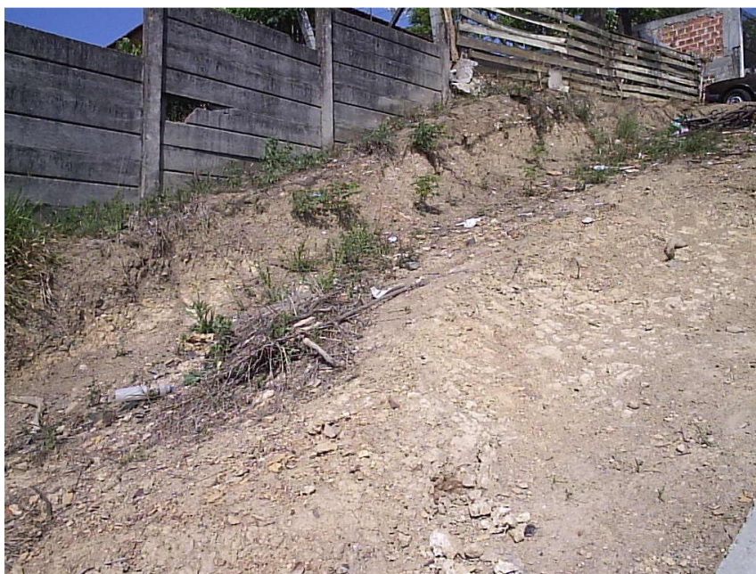
Figura 12: Vista parcial do Afloramento Rua João XXIII.
