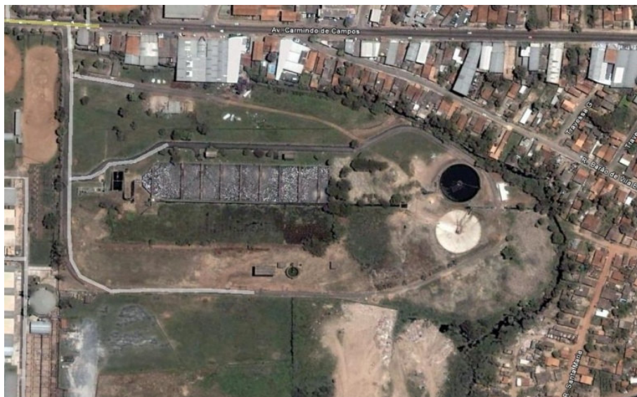
Figura 32: ETE Dom Aquino, principal Sistema de Tratamento de Esgoto de Cuiabá.
