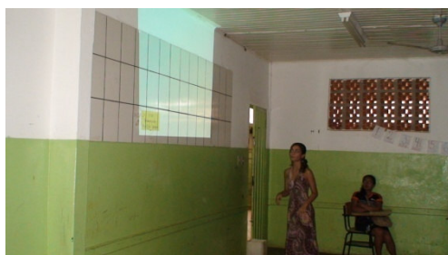
Figura 100: Falta de infra-estrutura.
