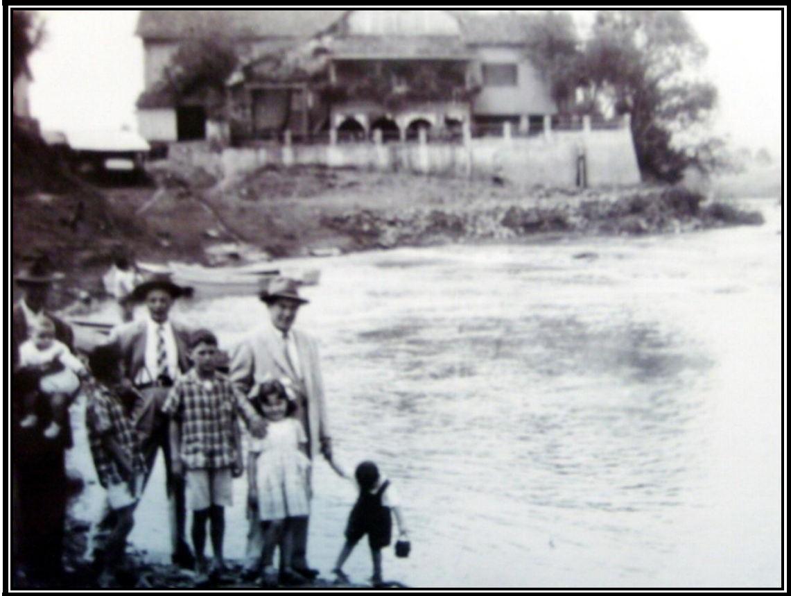
Fotografia 2 - Ao fundo casa sede da Comissão de Estudos e Melhoramentos do Rio Iguaçu em Porto Amazonas (PR) - Dec.de 1940
