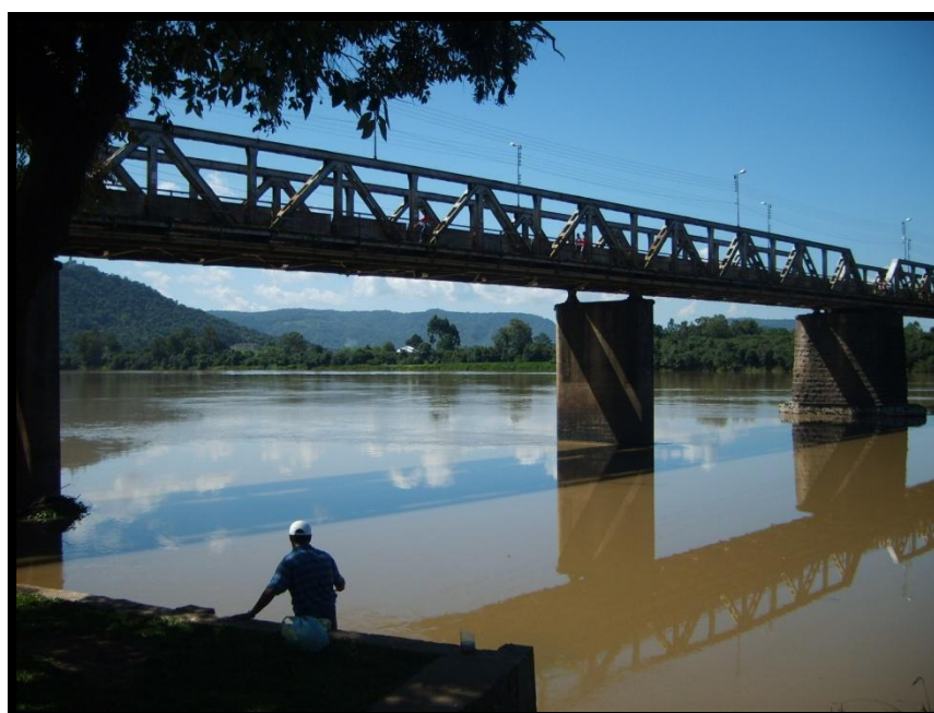
Fotografia 3.16 - Ponte Machado da Costa. Utilizada inicialmente pela Ferrovia São Paulo – Rio Grande
