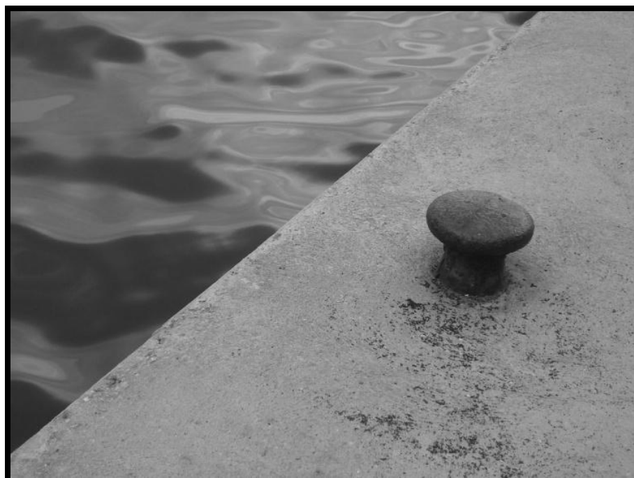
Fotografia 3.8 - Amarra de ferro no Cais de Porto Amazonas (PR)
