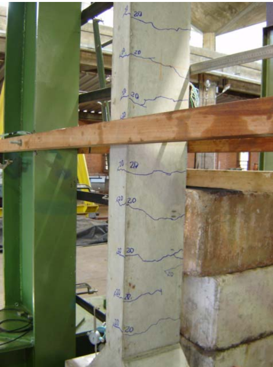
Figura 4.6 – Fissuras do pilar PFN30-3
