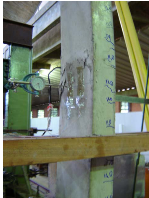
Figura 4.11 – Ruptura do pilar PFN50-3
