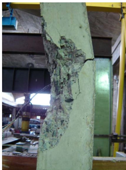
Figura 4.3 – Ruptura do pilar PFN0-3
