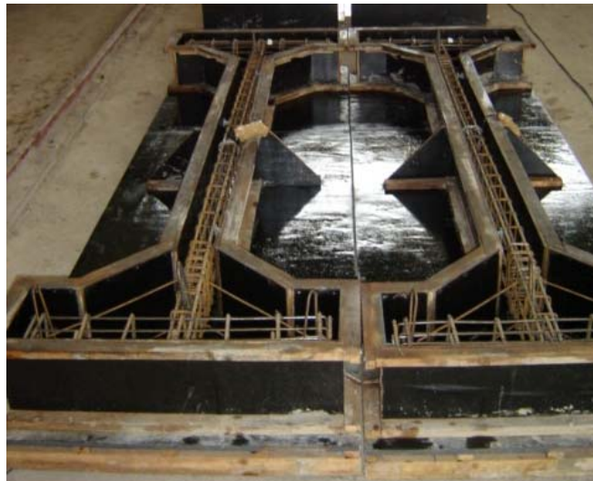
Figura 3.7 – Fôrmas com armaduras
