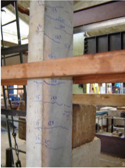
Figura 4.8 – Fissuras do pilar PFN40-3
