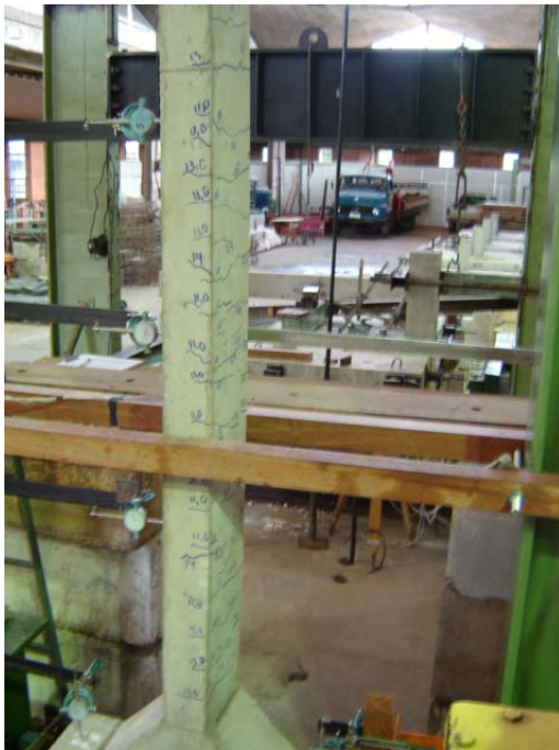
Figura 4.10 – Fissuras do pilar PFN50-3
