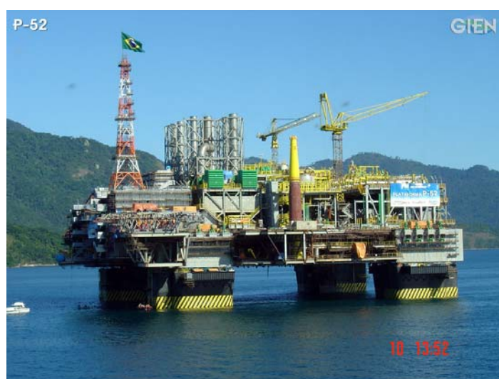
Figura 5-1 – Foto da plataforma P-52 após instalação do topside através de operação de deck matting em Angra dos Reis.
