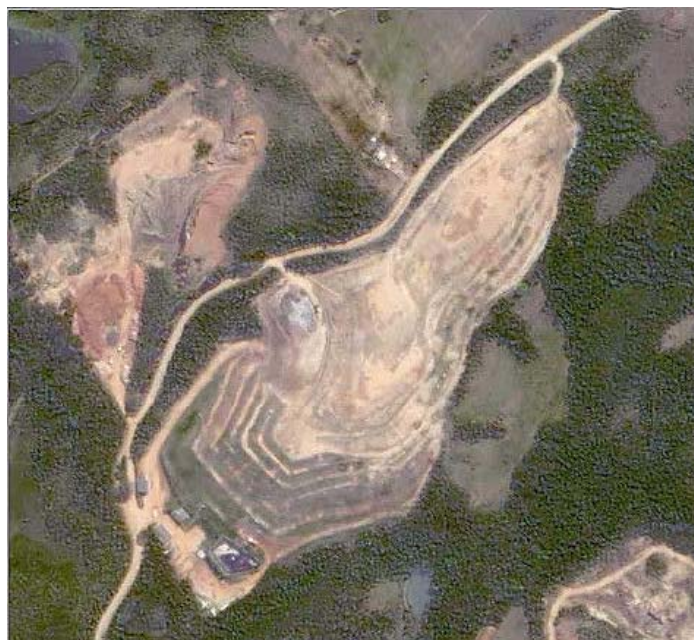
Figura 2.12 – Vista aérea do aterro. Fonte: imagem do satélite QuickBird® apud DMLU (2004).
