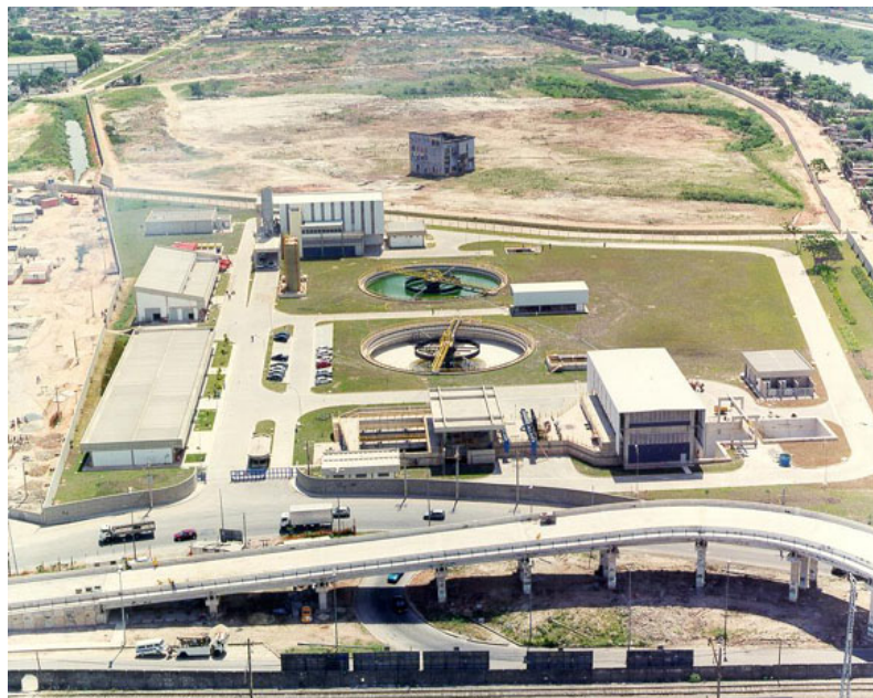
Figura 2.4 – Estação de Tratamento de Esgotos Pavuna – Rio de Janeiro Fonte: Aquacon (2006).
