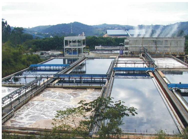
Figura 2.6 – Central de tratamento de efluentes industriais: Papel e Celulose. Fonte: Centroprojekt (2006).
