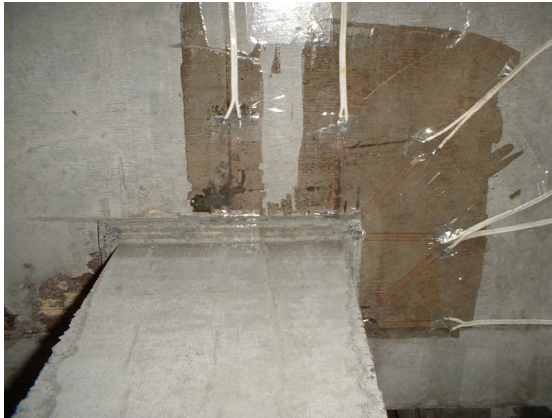
(b) – Colagem dos extensômetros do concreto com a laje invertida para esta operação.
