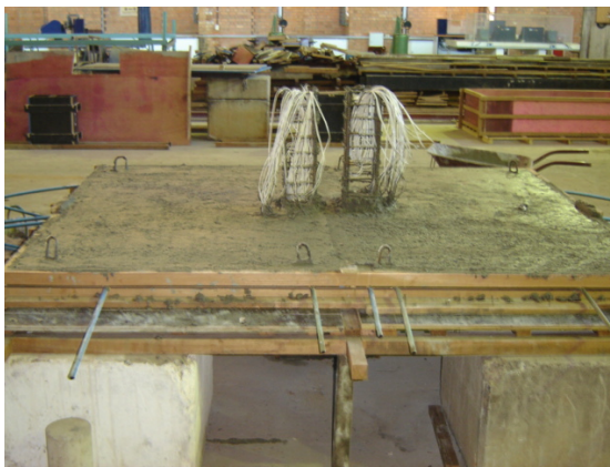
(a) – Acabamento preliminar das lajes
