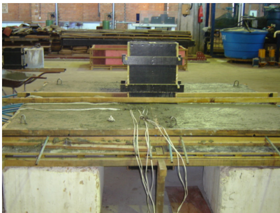
(a) – Forma dos pilares em posição
