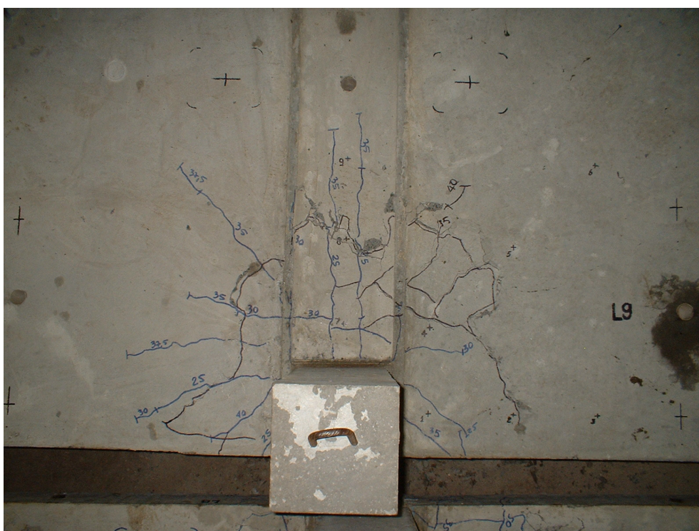
Figura 4.40 – Ruptura da laje do modelo L9.
