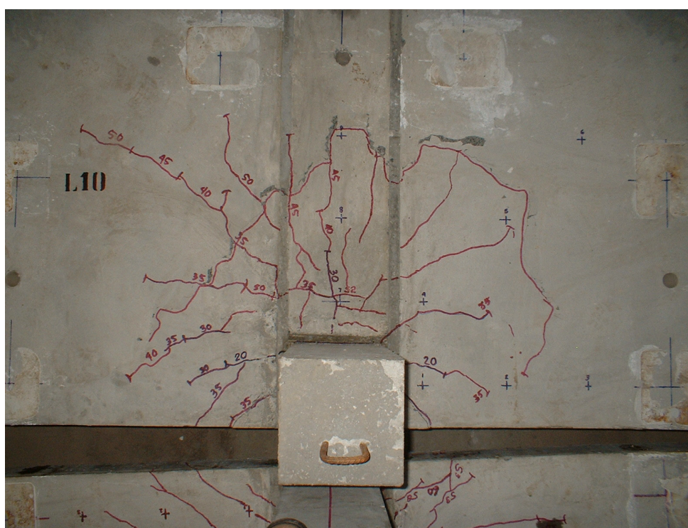
Figura 4.41 – Ruptura da laje do modelo L10.
