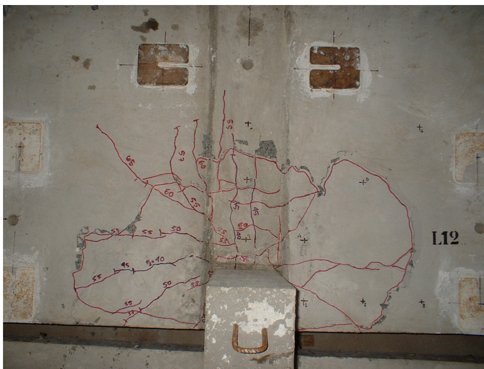
Figura 4.43 – Ruptura da laje do modelo L12.
