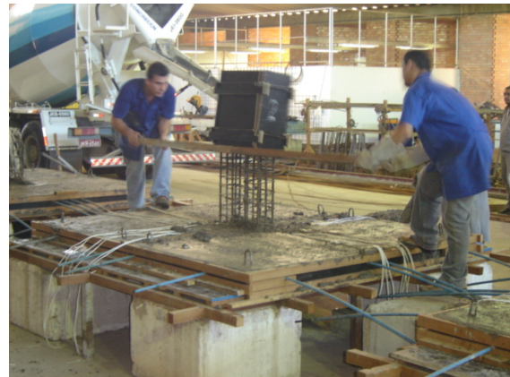
(b) – Colocação das formas dos pilares
