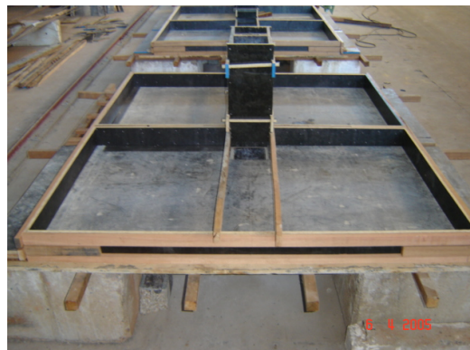
(b) – Vista frontal de um dos blocos de fôrmas
