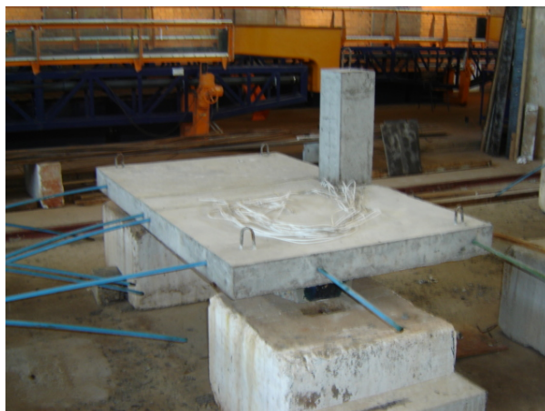
Figura 3.7 – Ganchos nas lajes após a concretagem dos modelos.
