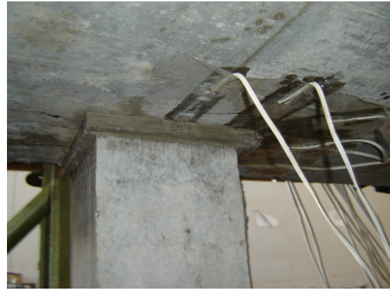
(c) – Laje posicionada para ensaio.
