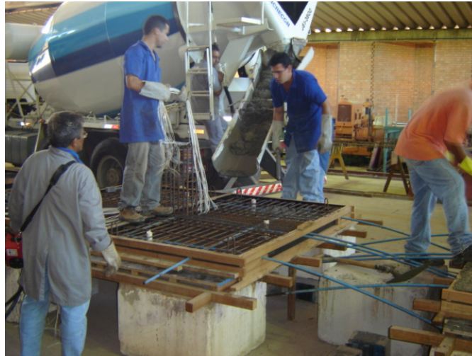
Figura 3.19 – Fios de instrumentação sendo mantidos fora da forma das lajes.
