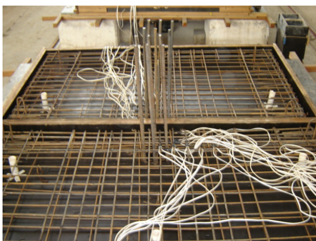
Figura 3.8 – Canos de PVC fixados nas fôrmas.
