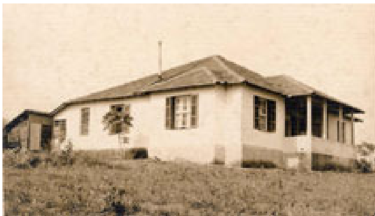
FIGURA nº 2: Primeiras instalações da UniEVANGÉLICA Fonte: UNIEVANGÉLICA (2008 b).
