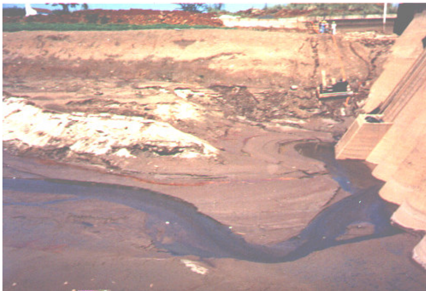
FIGURA 08 – Vista Parcial do Reservatório de Cariobinha (Convênio CPFL/UNICAMP Coiado, 2001)
