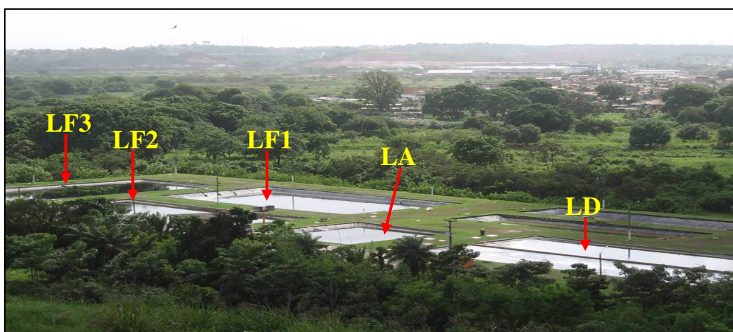
Figura 3.2: Estação de tratamento de lixiviado (ETC) do Aterro da Muribeca, PE.
