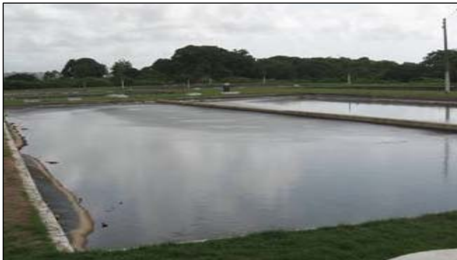
Figura 3.17: Local onde é retirado o Lixiviado Bruto (lagoa de Decantação)
