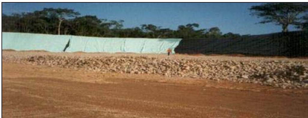
Figura 2.5: Detalhe da colocação da brita do filtro anaeróbio na base do patamar de cotas mais baixas do aterro.
