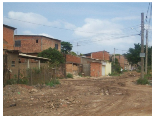
Ilustração 36 - Obras de Drenagem no N. R. Gênese. Fonte: Autora, 2008
