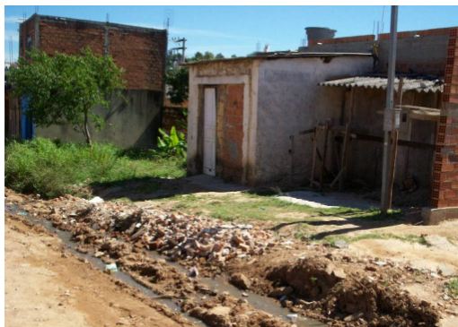
Ilustração 42 - Rua que não receberá Pavimentação e Drenagem - Jd. Monte Cristo. Fonte: Autora, 2008
