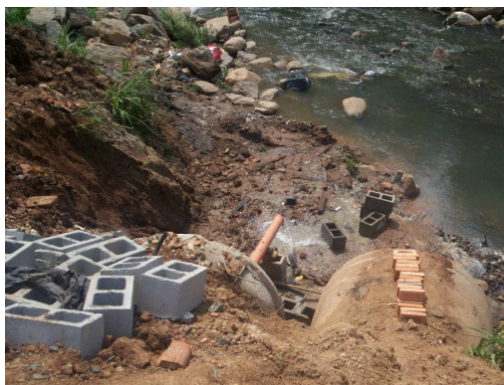
Ilustração 35 - Obras de Saneamento. Fonte: Autora. 2008
