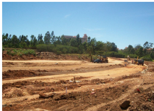
Ilustração 43 - Rua que receberá Pavimentação e Drenagem - Jd. Monte Cristo. Fonte: Autora, 2008
