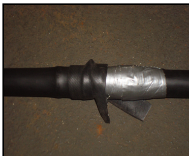
Figura 6 – Processo de vedação dos gotejadores
