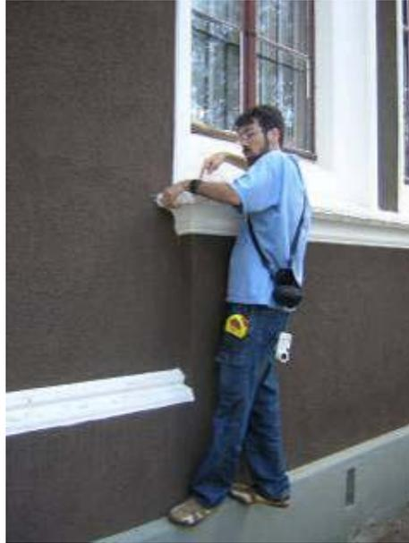
Figura 21 - Foto do levantamento das medidas à trena para o detalhamento de esquadrias. Fonte: Acervo próprio, 2005.
