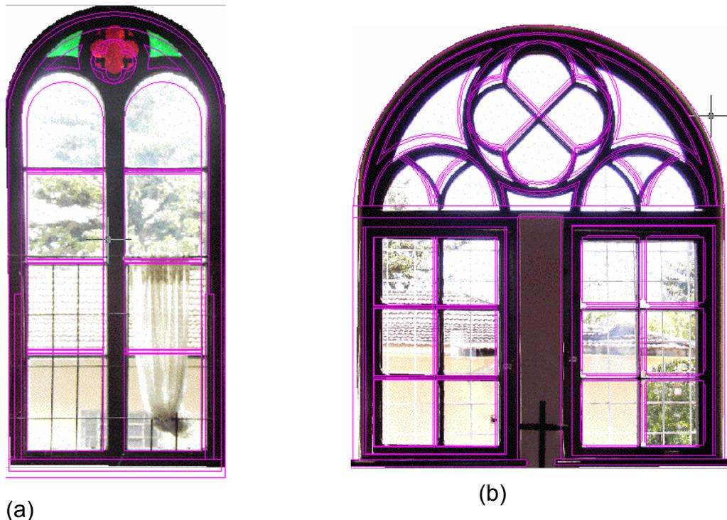
Figura 49 - Fotografia da janela da nave (a) e do altar (b), sobrepostas sobre o levantamento e documentação gráfica realizada pela equipe de arquitetos para a realização do projeto de restauro
