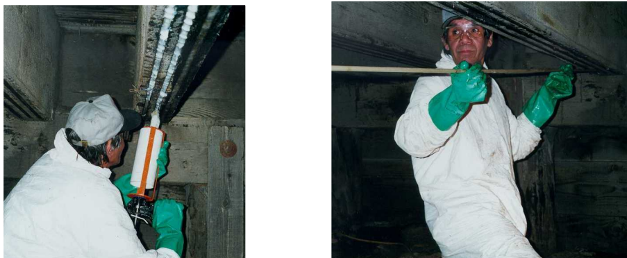
Figura 2.7 – Instalação do reforço com a técnica NSMR (Rizkalla, 1999)
