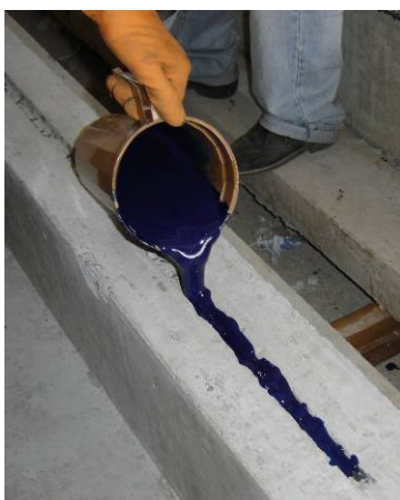
Figura 3.35 – Aplicação da resina no entalhe
