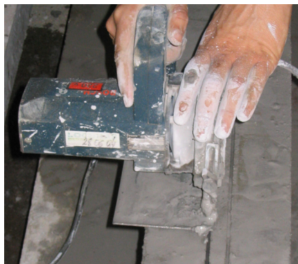
Figura 3.30 – Corte do concreto com a serra mármore via úmida
