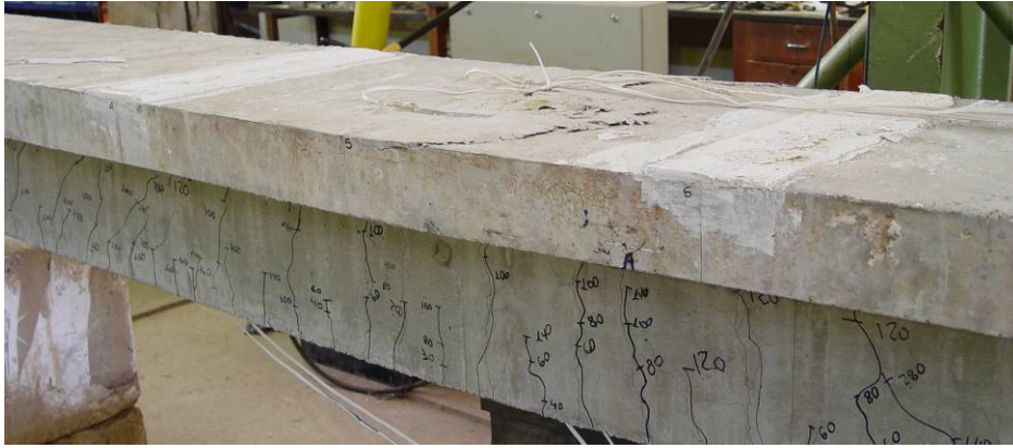
Figura 4.42 – Detalhe do concreto na viga VB – RBA após a ruptura
