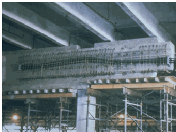
Figura 2.3 – Aplicação de protensão exterior (Rizkalla, 2001)
