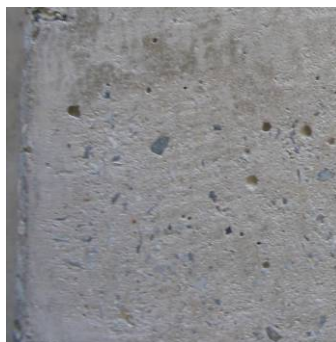
Figura 3.39 – Superfície do concreto para colagem da manta de FRP
