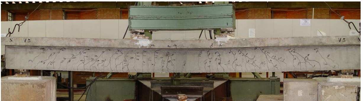
Figura 4.60 – Fissuração na viga VB – REF, após o ensaio
