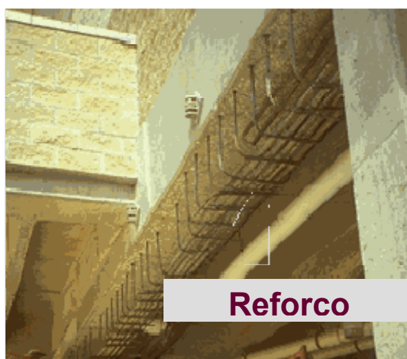
Figura 2.1 – Reforço por aumento de seção (Rizkalla, 2001, com adaptações)
