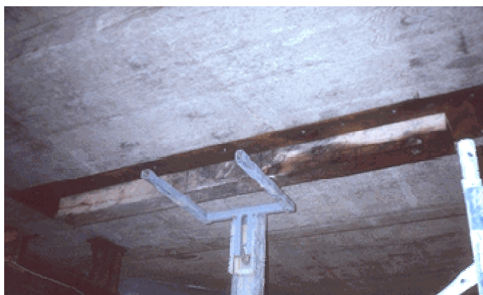
Figura 2.2 – Adição de chapas de aço metálicos (Rizkalla, 2001)
