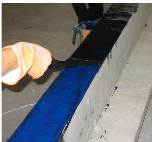
Figura 3.45 – Aplicação da segunda camada da manta de CFRP
