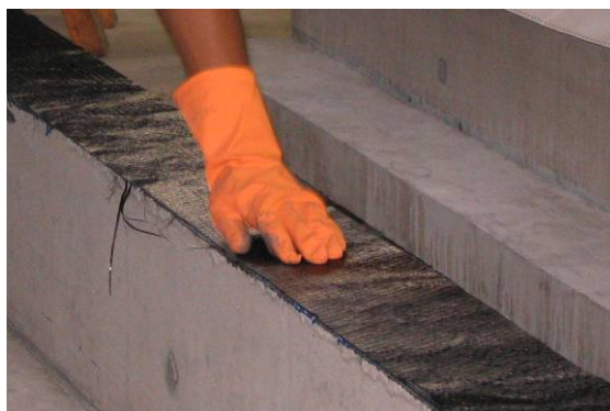
Figura 3.43 – Posicionamento da manta de CFRP na viga
