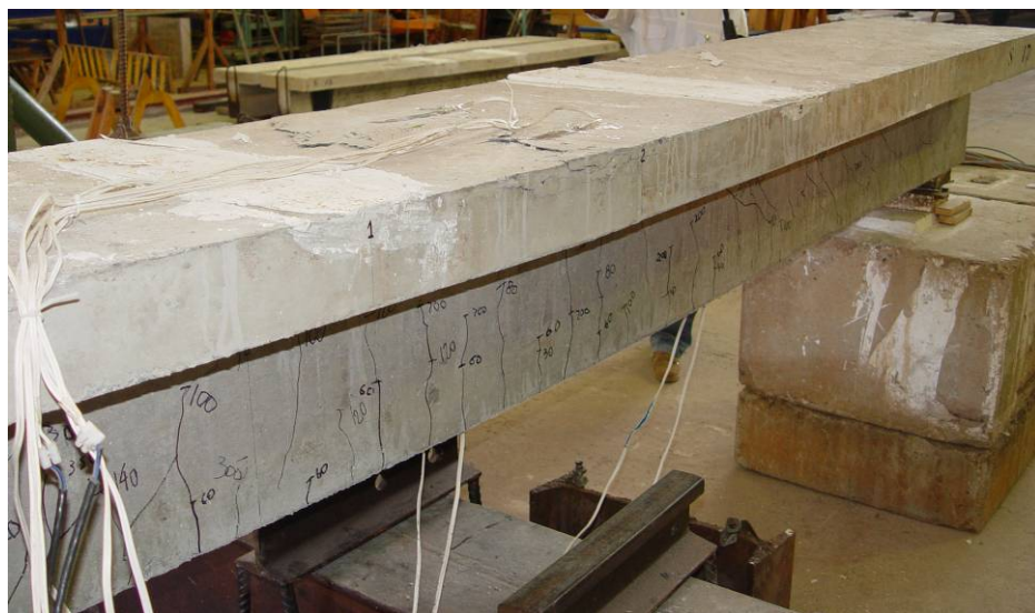
Figura 4.43 – Viga VB – RBA após a ruptura
