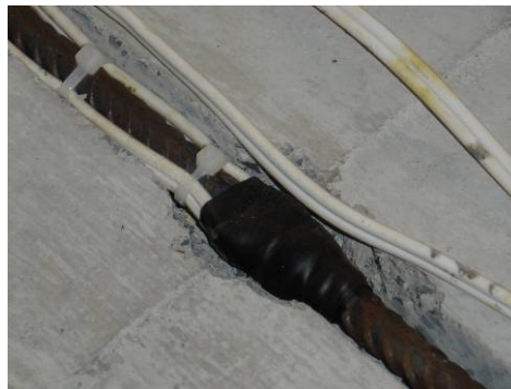
Figura 3.31 – Detalhe do reforço na região do extensômetro
