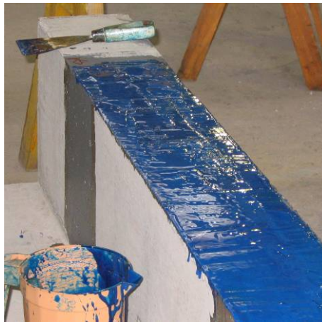
Figura 3.42 – Impregnação da superfície de concreto com Epóxi Estruturante FC
