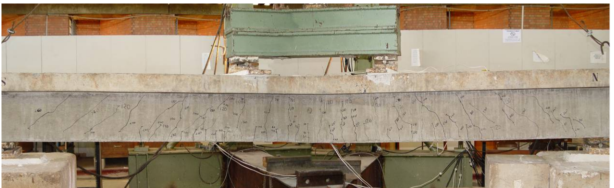
Figura 4.61 – Fissuração na viga VB – RBA, após o ensaio
