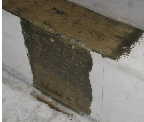
Figura 3.40 – Substrato impregnado com primer epóxico FC
