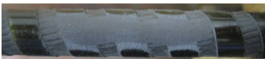
Figura 3.21 – Regularização da superfície das barras de CFRP
