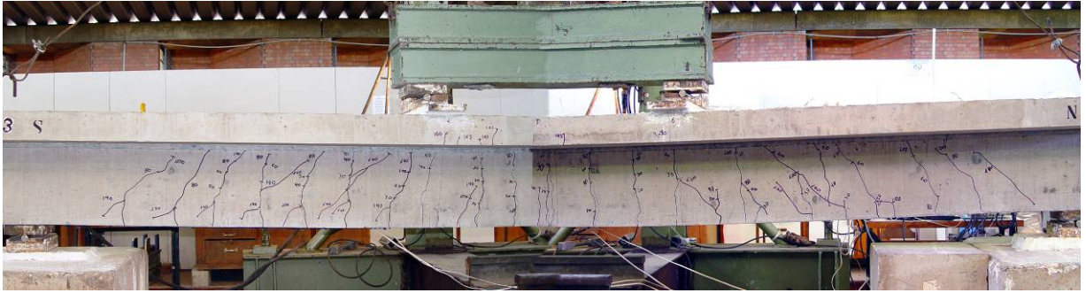
Figura 4.58 – Fissuração na viga VA – RBA, após o ensaio
