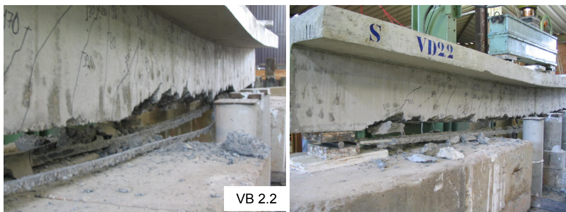
Figura 2.25 – Detalhes da ruptura das vigas VB 2.2 e VD 2.2 (Castro et al, 2004)
