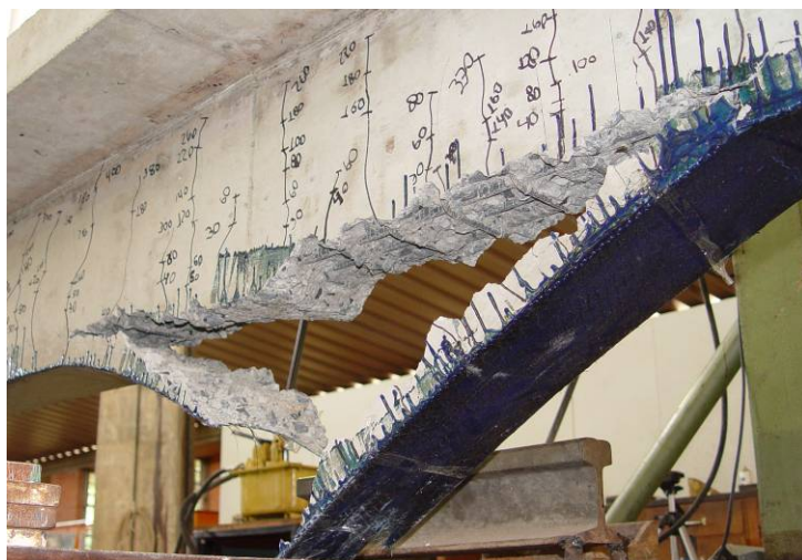
Figura 4.44 – Detalhe da ruptura do reforço na viga VB – RMC
