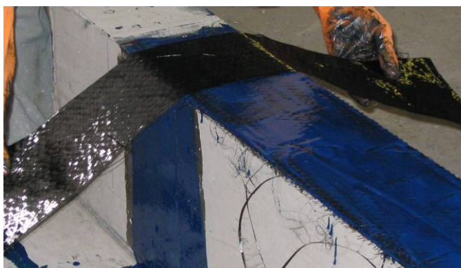
Figura 3.46 – Aplicação da gravada de ancoragem do reforço com MFC
