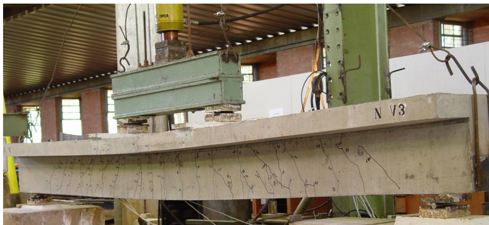
Figura 4.24 - Viga VA – RBA após o ensaio
