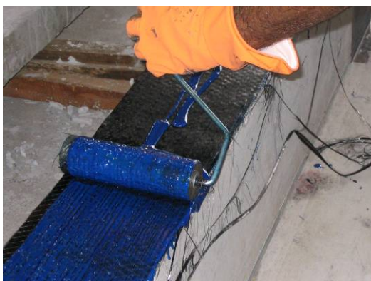
Figura 3.44 – Impregnação da manta de CFRP com a resina saturante
