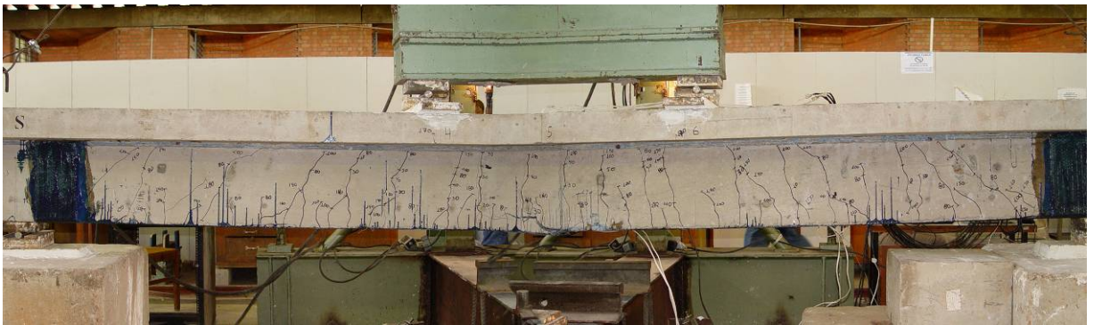
Figura 4.59 – Fissuração na viga VA – RMC, após o ensaio
