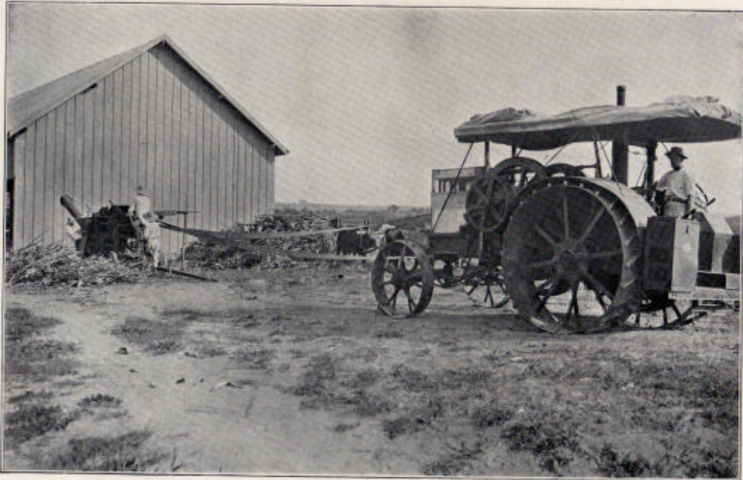
Estação Experimental — Tractor accionando uma descascadora
